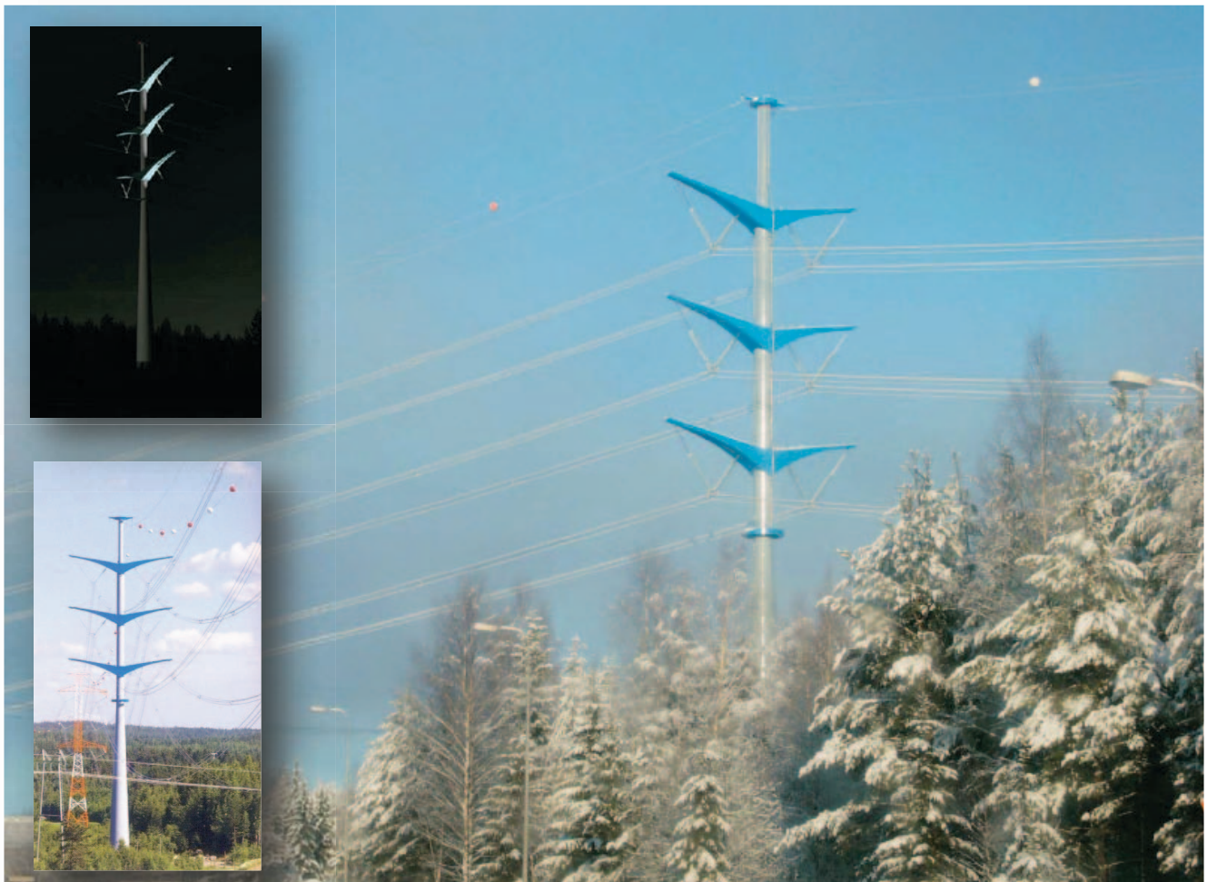
Figure 40 - Lempäälä.Konehuone / J. Valkama
